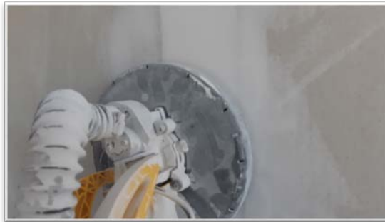
Aux travaux dans les bâtiments communaux : ponçage, rainurages, saignées dans des murs de béton, malaxage et projeté d'enduit de façade, etc.
