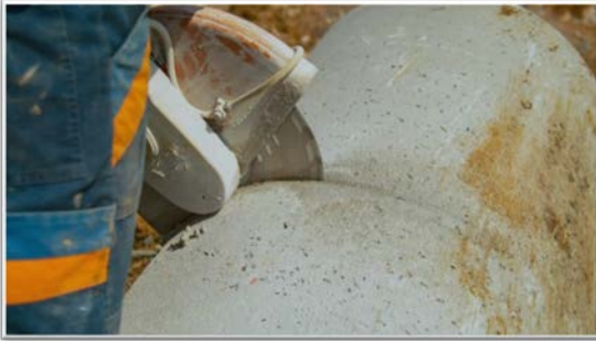
Aux réseaux d'eau et d'assainissement : découpage de tuyaux...
